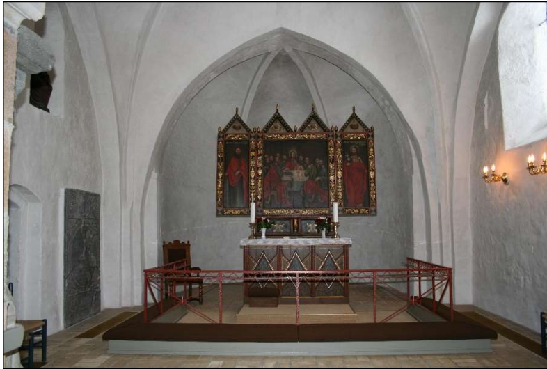
Spidsbuen, som blev bygget i stedet for den ældre rundbue
